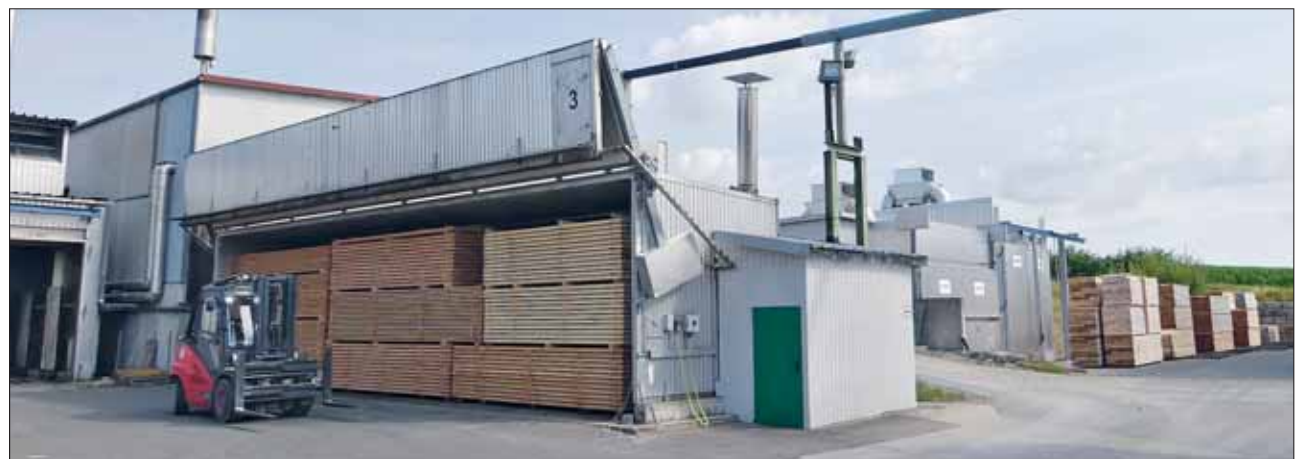
Wichtigste Wärmeverbraucher sind die Trockenkammern; im Hintergrund die neueste (alle von Mühlböck).
