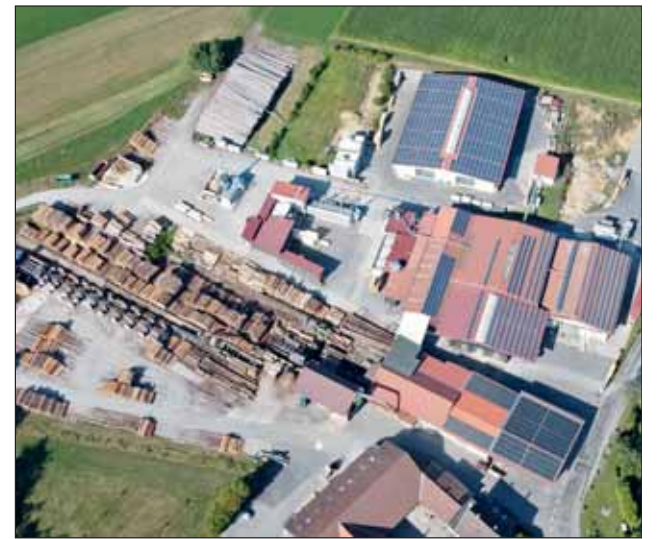
Blick auf das Holzwerk Bay in Großlacher: Gut zu erkennen sind der Standort der neuen Heizzentrale und die großflächigen PV-Anlagen auf den Hallendächern. Fotos (3): Bay
